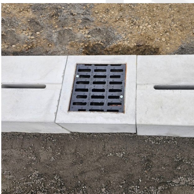
Kecskemét, Mercedes gyár, RFA 46/46/100 résfolyóka akna fedlappal
