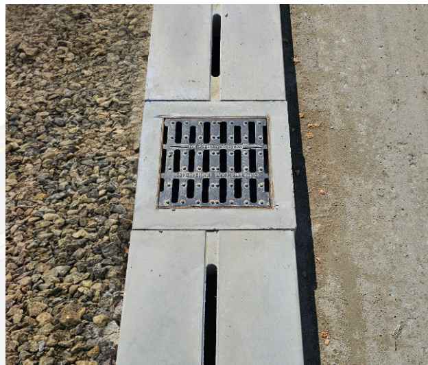
Kecskemét, Mercedes gyár, RFA 46/46/100 résfolyóka akna fedlappal
