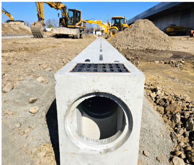
Kecskemét, Mercedes gyár, RFA 46/46/100 résfolyóka akna beépítés közben
